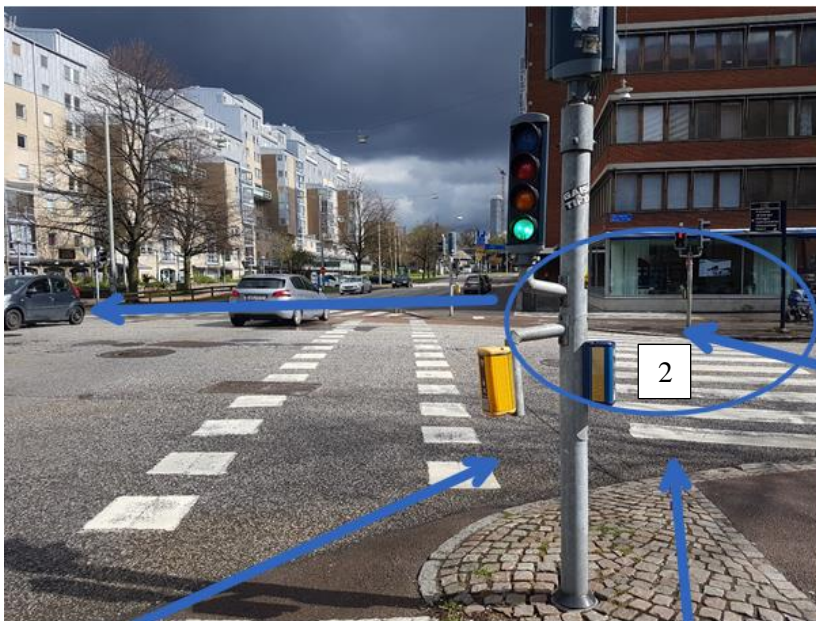
Figur 20. Bild tagen vid ett platsbesök 2020-04-28 för att illustrera hur avrinningen (blå pilar) leds till och från lågpunkt 2 (blå cirkel). Vatten ansamlas vid den blå cirkeln tills det bräddar över Engelbrektsgatan norrut för att avrinna längs Sten Sturegatan mot Heden (pilen riktad vänster i bilden). Bilden är tagen från Engelbrektsgatan i riktning mot Skånegatan med Sten Sturegatan höger i bilden.
