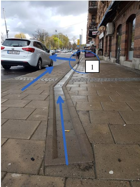
Figur 19. Bild tagen vid ett platsbesök 2020-04-28 för att illustrera hur avrinningen (blå pilar) leds mot lågpunkt 1 intill de gamla fastigheterna (blå cirkel) där skyfallsstråk 2 korsar Engelbrektsgatan. Vatten ansamlas vid den blå cirkeln tills det bräddar över Engelbrektsgatan norrut mot Heden (pilen riktad vänster i bilden). Bilden är tagen längs med Engelbrektsgatan i riktning mot Skånegatan.
